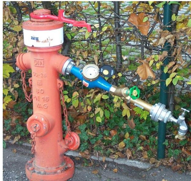
Bild 2. Hydrantenzähler für Überflurhydranten
